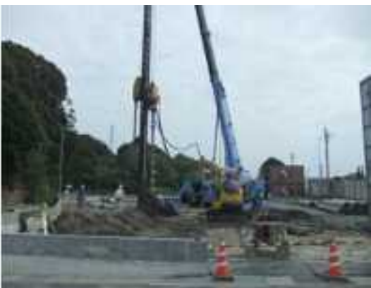
西部すみれの家 建設現場
