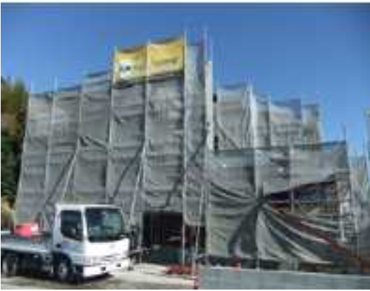
藤枝市水上 西部すみれの家建設現場
