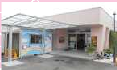
外壁塗装工事&雨除け設置工事完了
